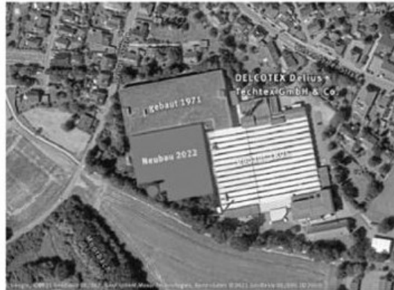
Auf dem hinteren Teil des Geländes wird die neue Halle zwischen Gebäuden aus den Jahren 1971 und 1895 gebaut. FOTO: DELCOTEX
